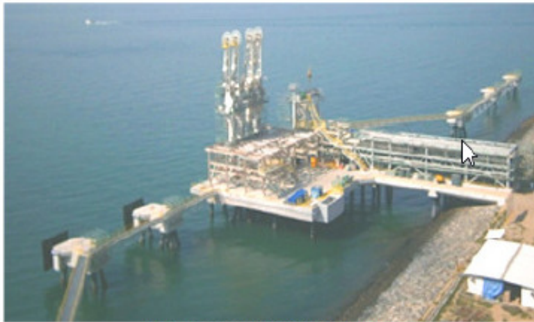
Singapore LNG terminal jetty
